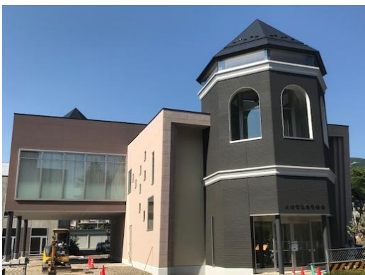
建設中の大村記念学術館
